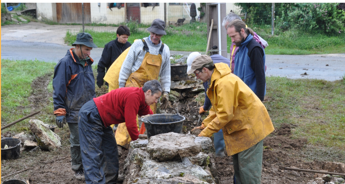
Figura 5. Creación de un muro de piedra seca con doble línea. Francia. Fuente: Poncetdespontets (CC BY-SA 4.0)
