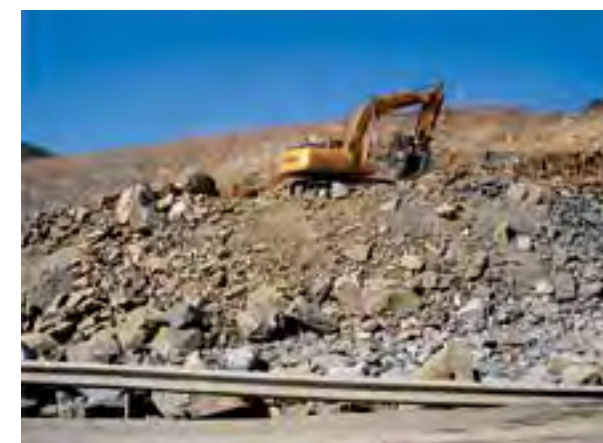
Figura 5. Movimiento de tierras y generación de taludes durante la construcción de una autopista (Foto: Nerea Aizpurua y Adoración Gómez).
