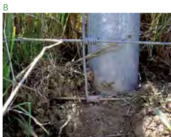
Figura 3. Ejemplos de buenas prácticas en cerramientos: vallado especial para evitar el acceso de anfibios a la calzada (A), ubicado en un tramo conflictivo por el paso estacional de anfibios en la carretera M-618 (Madrid), y detalle de vallado enterrado en la base (B) en la autopista AP-51 en la provincia de Ávila.
