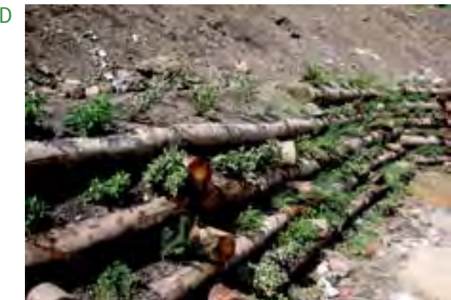
Figura 13. Entramado sencillo de una pared (A, tomado de Florineth 2004), entramado tipo 'Roma' (Paolo Cornellini, B), y entramado tipo 'Latina' (Paolo Cornellini y Sauli; 2005, C y D).
