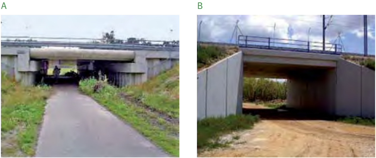
Figura 7. Pasos inferiores multifuncionales con adaptaciones para favorecer su uso por la fauna: con áreas revegetadas a ambos lados del camino en una autovía holandesa (A) y un paso con solado de tierra ubicado en un tramo de la provincia de Guadalajara del TAV Madrid-Barcelona (B).
