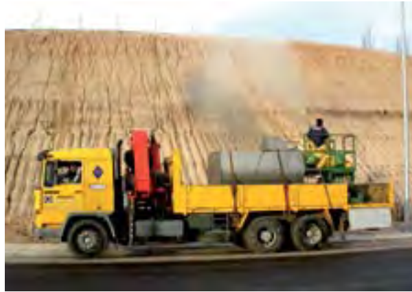
Figura 10. La hidrosiembra es una técnica habitual para sembrar semillas en amplias superficies, como los taludes que se generan al crear vías de transporte. La hidrosemebradora consiste en un vehículo equipado con un tanque o cisterna en cuyo interior se mantiene en el cóctel en permanente agitación para asegurar una mezcla homogénea. Los modelos de mayores dimensiones, como el que aparece en la imagen, cuentan con una torreta en la parte superior desde la cual proyectar con una manguera la siembra (Foto: María Altamirano; OHL).
