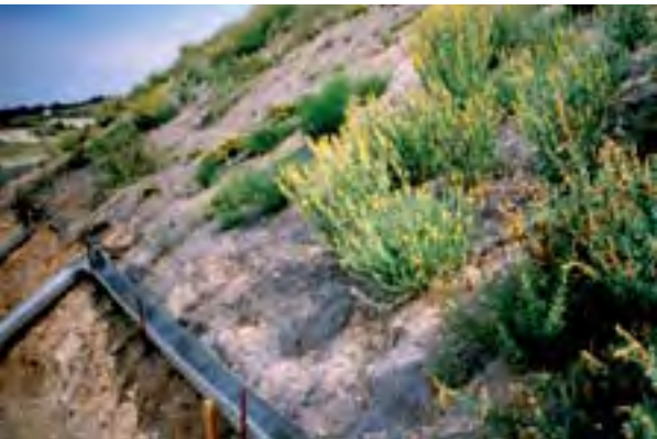
Figura 15. Vista del talud del ejemplo.
