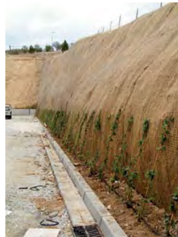
Figura 2. Manta orgánica combinada con un enrejado metálico en un talud del polideportivo de Alhama, Granada.
