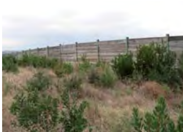
Figura 12. Ecoducto de tipo falso túnel construido en un tramo de la provincia de Cáceres de la autovía A-66 (A). Y detalle de la revegetación realizada en el interior del paso (B).
