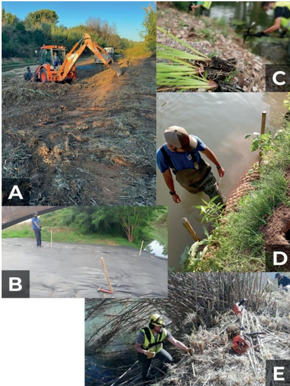
**Figura 2.** Diferentes tipologías de actuaciones enmarcadas en convenios de custodia fluvial. A: retirada de invasoras mediante retroexcavadora; B: colocación de malla para solarización; C: plantación de helófitos en primera línea de ribera; D: Colocación de biorrollos vegetados; E: desbroce de cañaverales.
